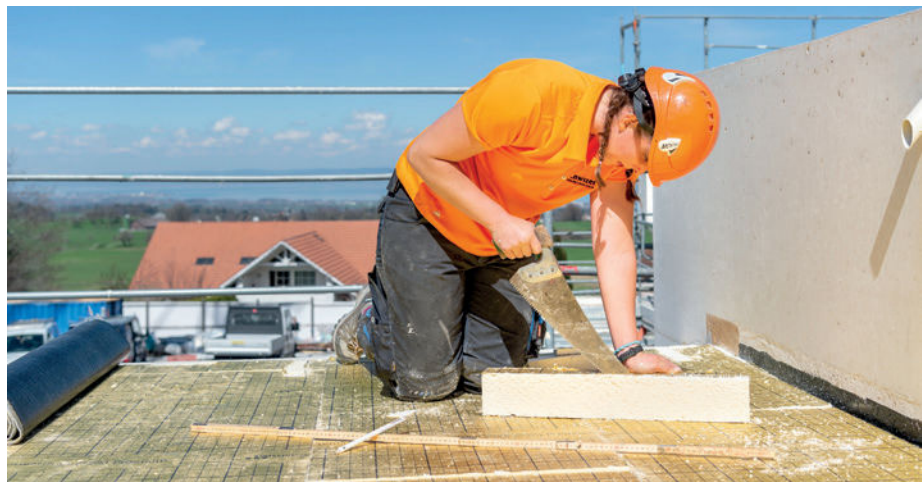
▲ Vor dem Abdichten schneidet Svenja German das Isolationsmaterial zu und installiert es.
